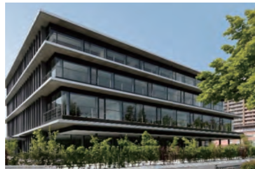
JAバンク滋賀 事務センタービル
