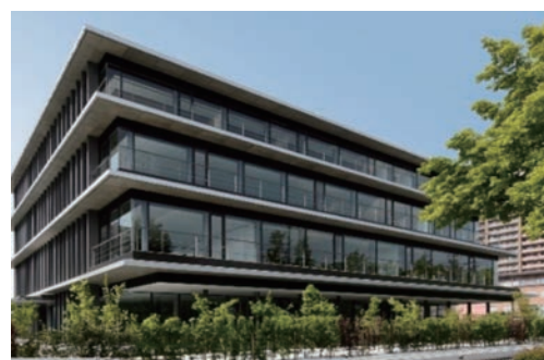
JAバンク滋賀 事務センタービル
