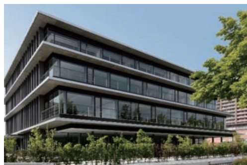
JAバンク滋賀 事務センタービル
