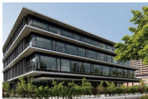
JAバンク滋賀 事務センタービル
