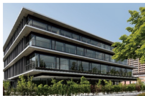
JAバンク滋賀 事務センタービル
