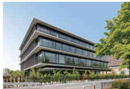
J A バンク滋賀 事務センタービル
